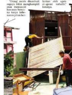
JKR sedang melakukan pemeriksaan keselamatan bangunan.
